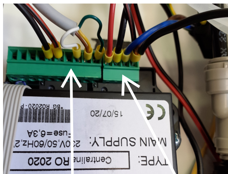
Morsettiera utenze A Morsettiera di potenza B
